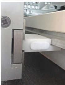
Der Beschlag, kurz bevor er durch die vorstehende Mauerlaibung nach außen geschoben wird
