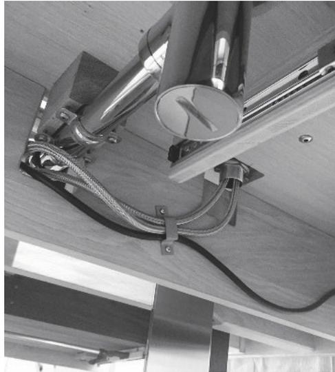
Abflussrohre, Armaturen und Leitungen wurden komplett provisorisch vormontiert und die Schubkästen an diese Installation angepasst
