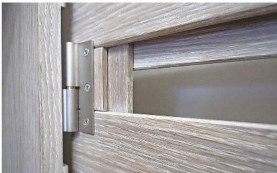
Dieses gekröpte Band steht auf dem Kopf. Die zwischenliegende Bandrolle ist auf Untermaß abgedreht
