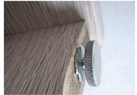
Rändelschrauben an den unteren Ecken helfen bei der Ausrichtung der Korpusse
