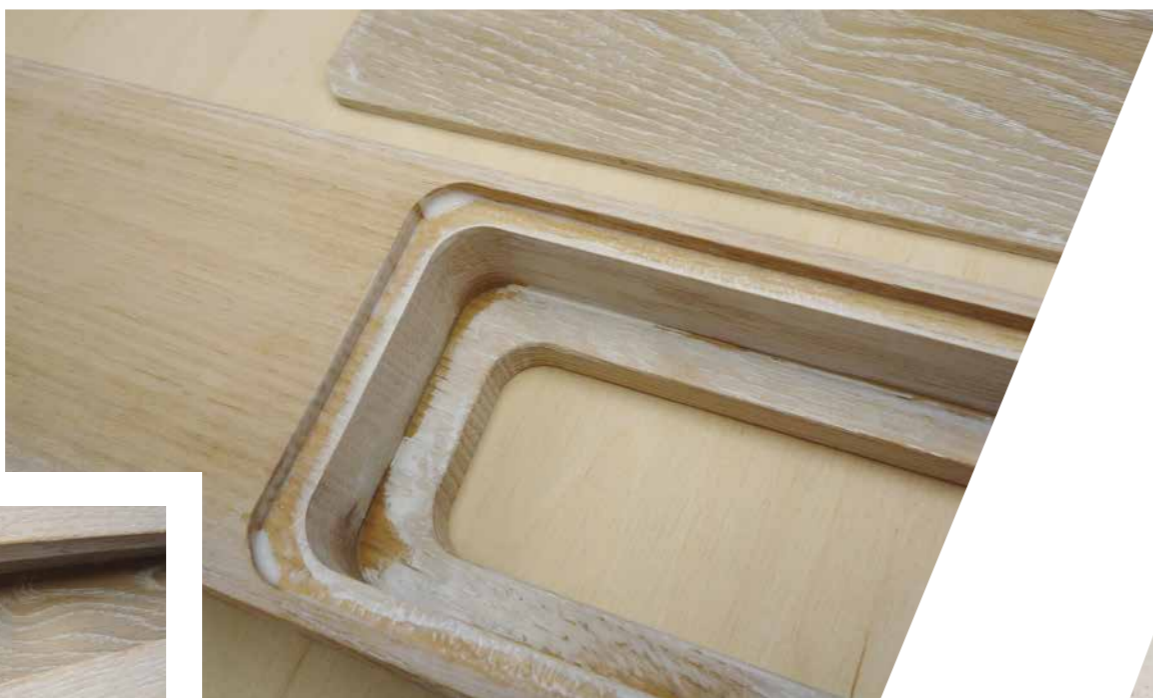
Die Griffmuschel der Schiebewand wurde rückseitig mit der CNC ausgefräst. Die oben umlaufende Nut für den seitlich liegenden Deckel ist aus Eiche.
