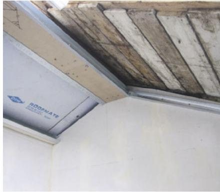
In die U-Profile wird eine Styrodur-Dämmung eingehängt und anschließend die Dampfsperre aufgeklebt
