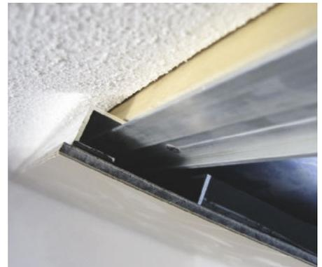
Das U-Profil der Unterkonstruktion greift in ein marktübliches Hängeschrankprofil ein. Etwas 2-K-Kleber schützt vor Verrutschen
