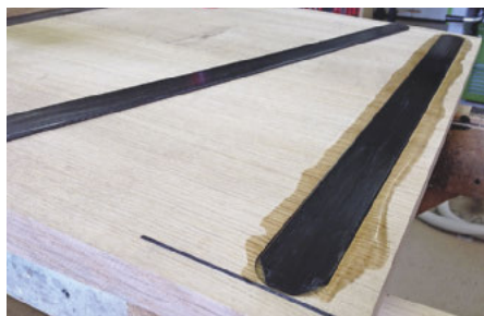
In beidseitig eingebrachte Nuten werden die CFK-Stangen mit Epoxidharz eingeklebt
