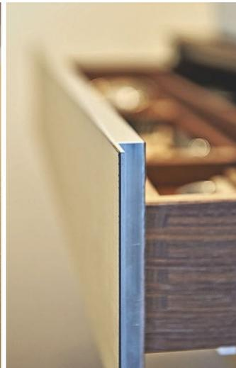
Durch angesetzte Aluminiumwinkel werden die sichtbaren Kanten auf eine feine Linie reduziert
