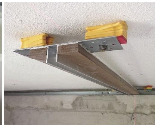
Deckenanschluss Duschwand: Die beiden Winkel sind mit Resysta so aufgefüttert, dass 12,5 mm Überstand für die Beplankung bleibt
