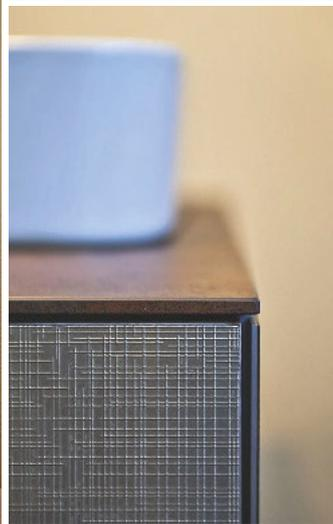
Auch in der Seitenansicht zeichnet die stumpf aufschlagende Schubladenblende eine präzise Schattenfuge
