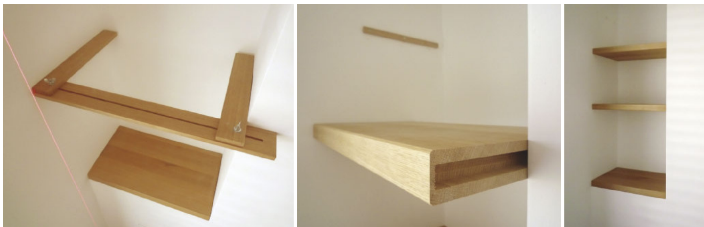
Das Abnehmen der tatsächlichen Maße mit der Winkelschablone hilft beim passgenauen Zuschnitt von Regalbrettern und Boden
